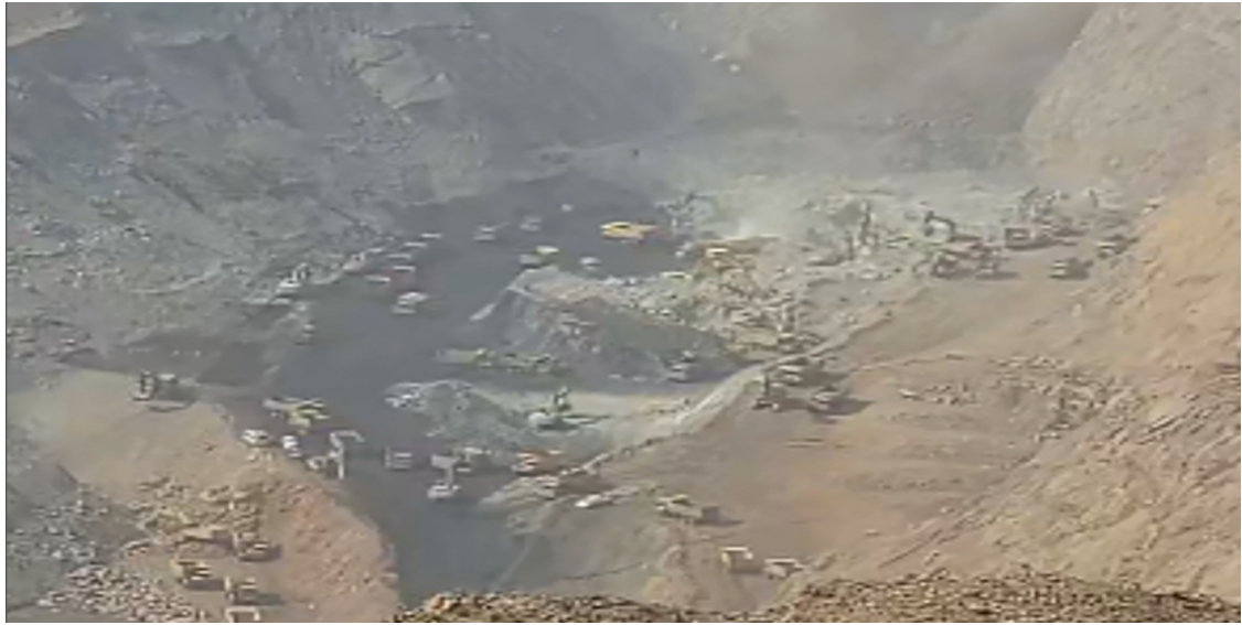
图 2 13 时许作业现场设备情况
