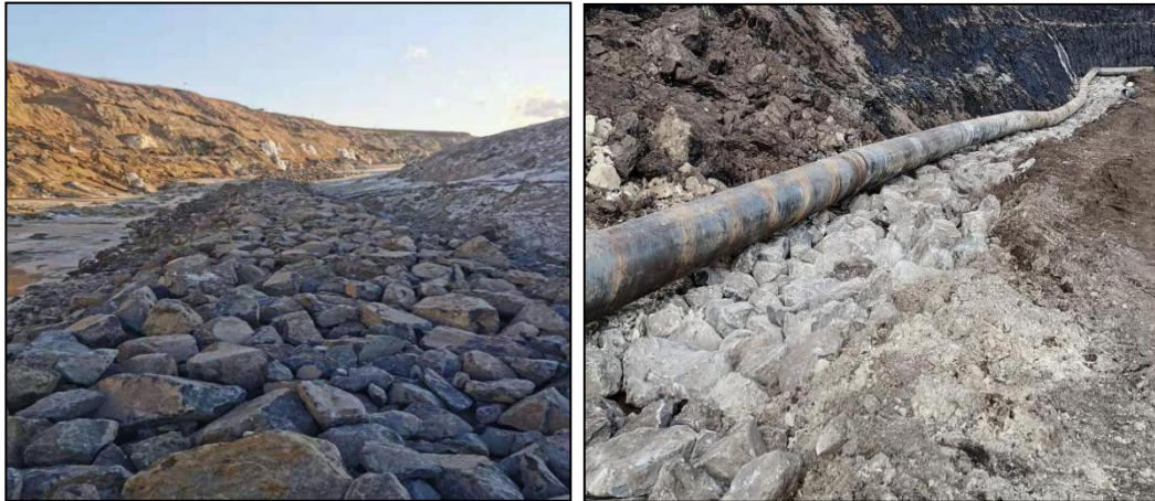
图 4 毛石盲沟铺设图
