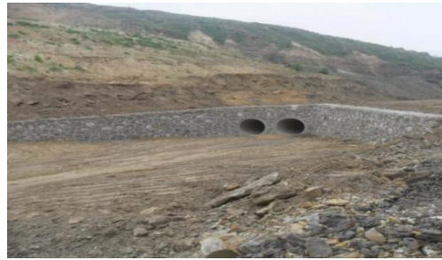
西曲矿矾石沟滑坡段治理（涵管）
