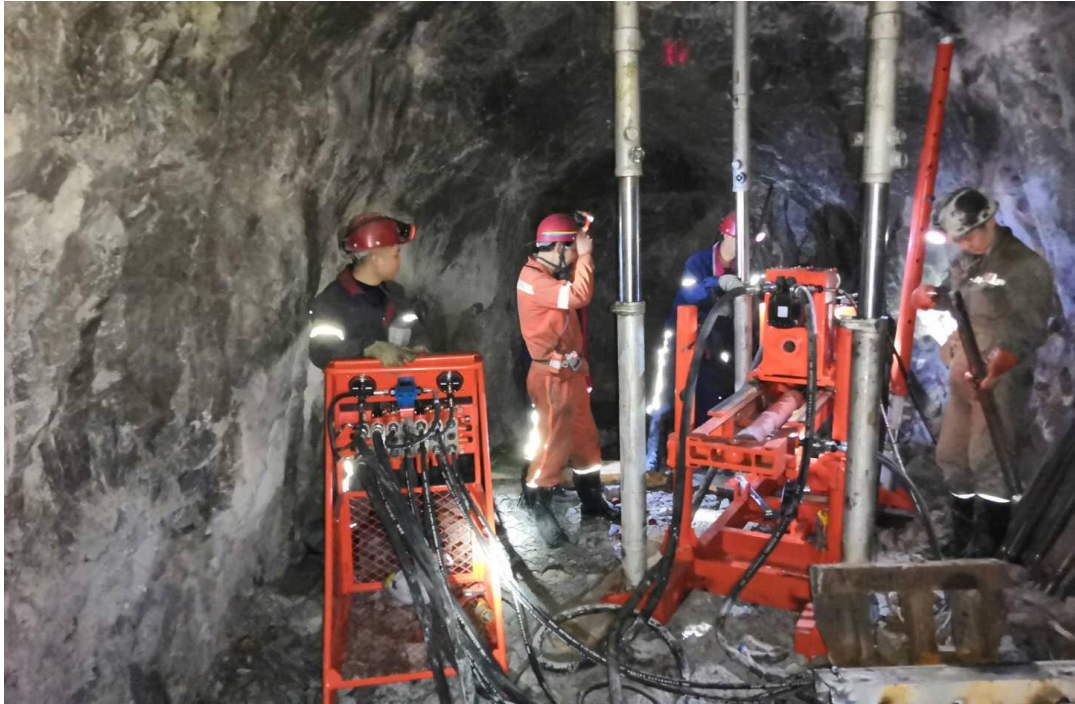
图 3 井下现场开展钻探施工作业
