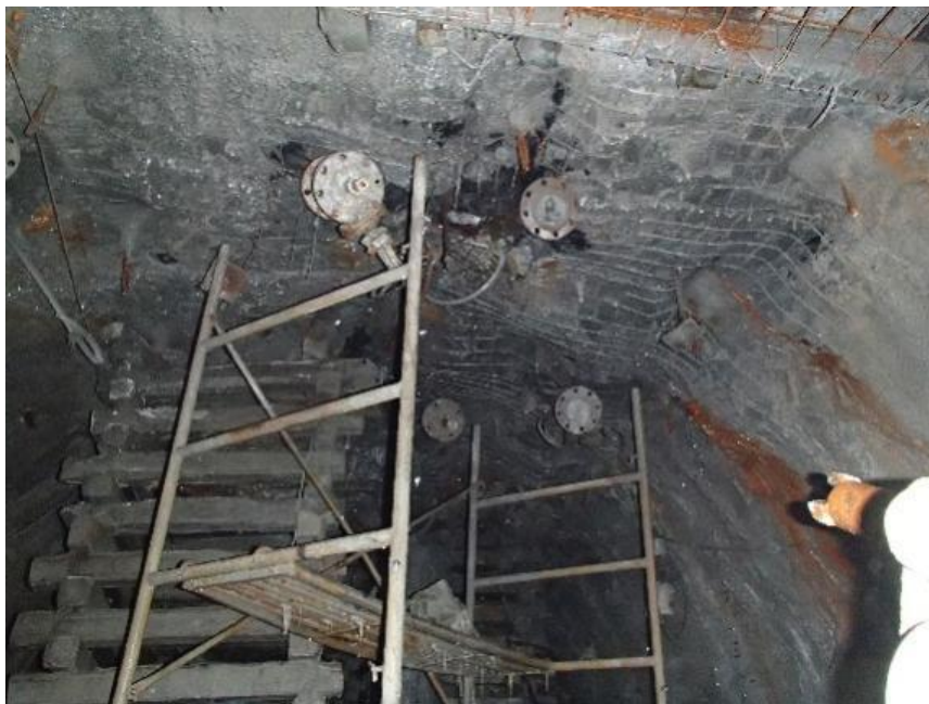
图 井下施工超前预注浆钻孔
