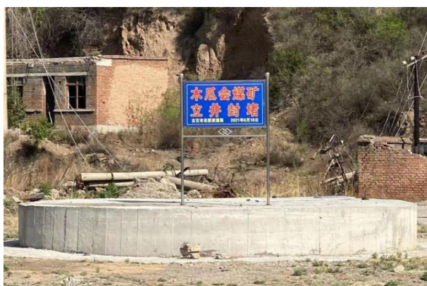
屯兰矿木瓜会煤矿主立井封堵
