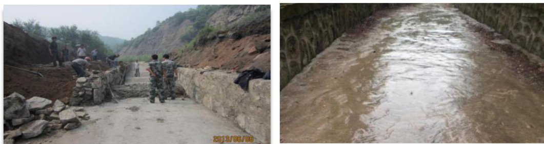
西铭矿磺厂沟河道治理前后对比图（片石砌坝混凝土铺底）
