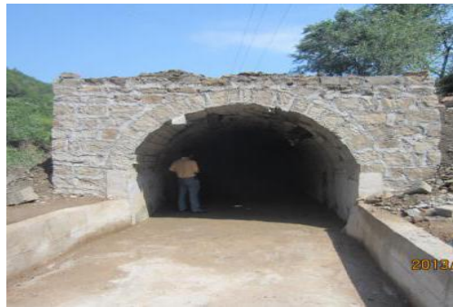
西铭矿磺厂沟滑坡段河道治理（涵洞）
