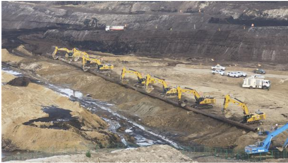
图 7 导水管涵铺设施工图
