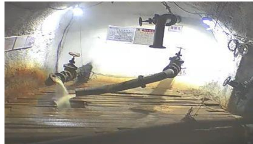
马兰矿北一暗斜防水闸墙
