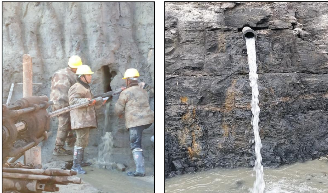
图 3 水平放水孔照片
