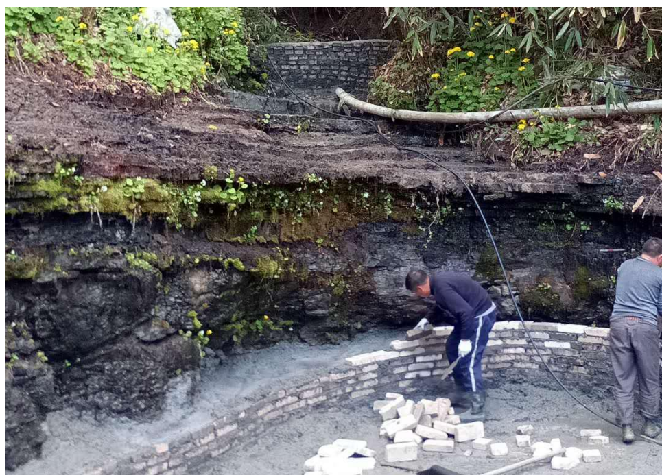
图 5 凹陷坑治理现场图片
