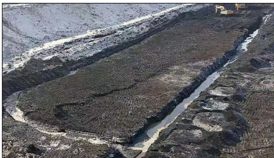
图 2 采煤工作面环沟降水
