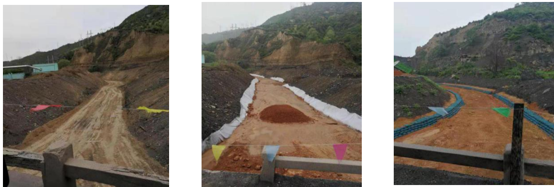
西曲矿矾石沟河道（土工布、强夯加粘土铺底）
