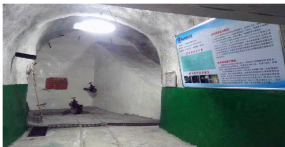
屯兰矿北一胶带巷防水闸墙
