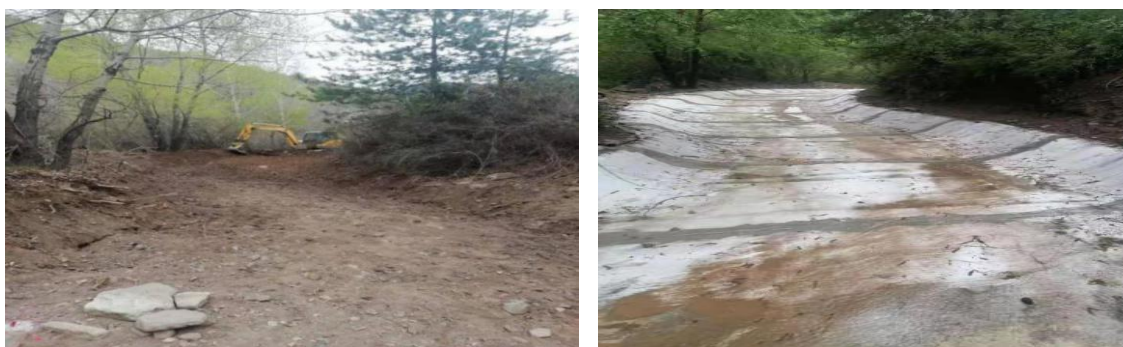
西铭矿冀家沟河道采用水泥毯方式治理
