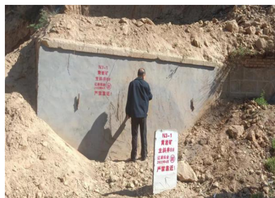
辽源煤业黄岩矿主斜井
