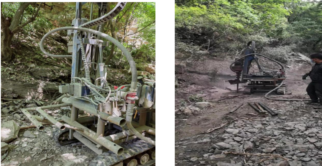
生辉煤业余家岭沟河床注浆治理
