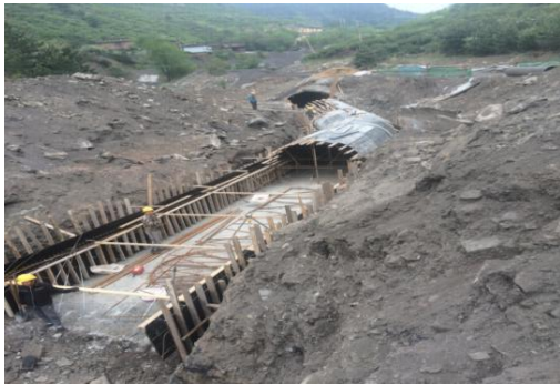
西铭矿磺厂沟滑坡段河道治理（涵洞）
