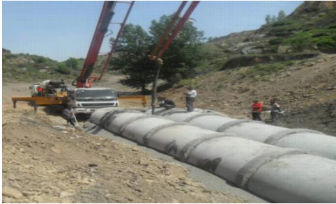
西曲矿矾石沟滑坡段治理（涵管）
