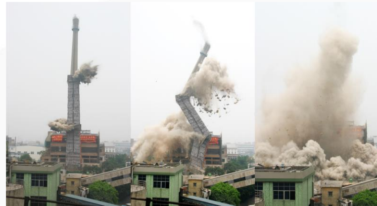
城市拆除工程
