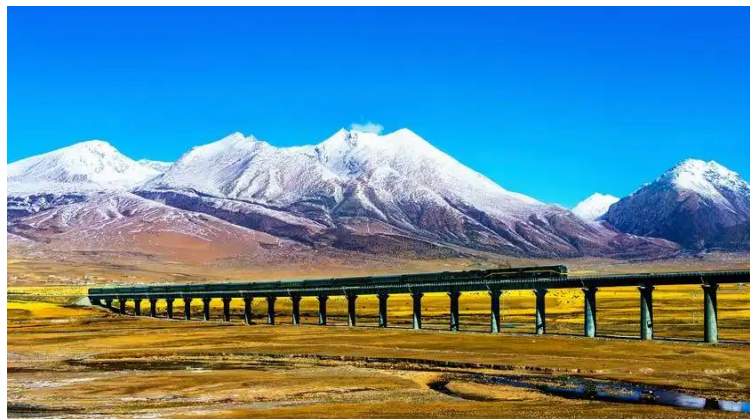
川藏铁路工程 90%的铁路隧道爆破掘进。
