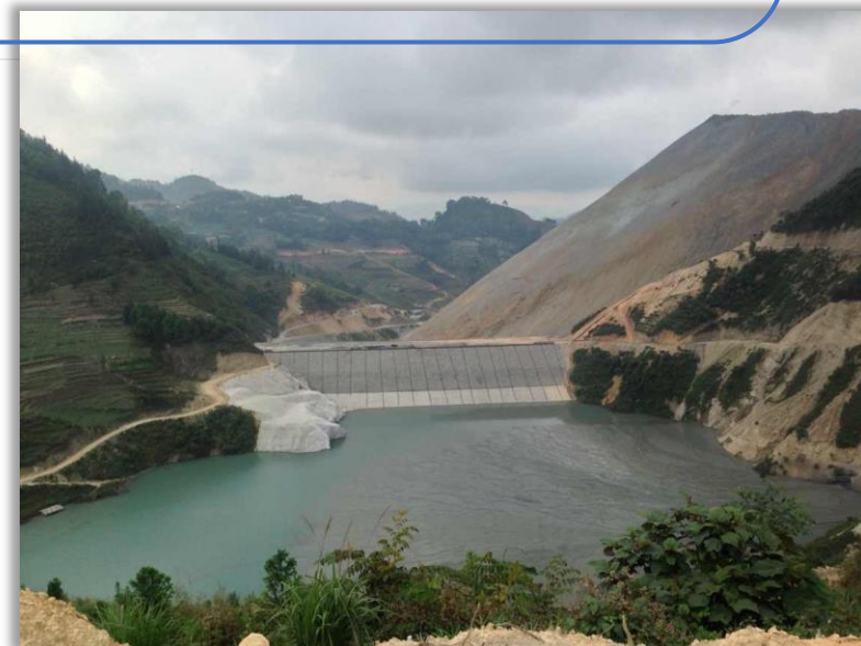
华联锌铟矿铜街大沟尾矿库 总库容3550万 m^3 总筑坝量1100万 m^3
