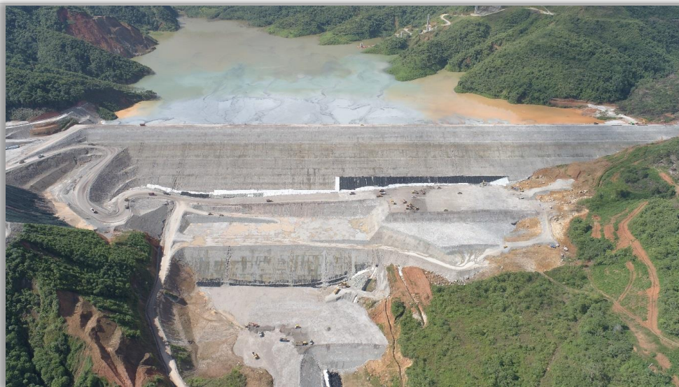
厄瓜多尔铜达伊米尾矿库 总坝高260m，总库容4.47亿 m^3 总筑坝量6.4亿 m^3
