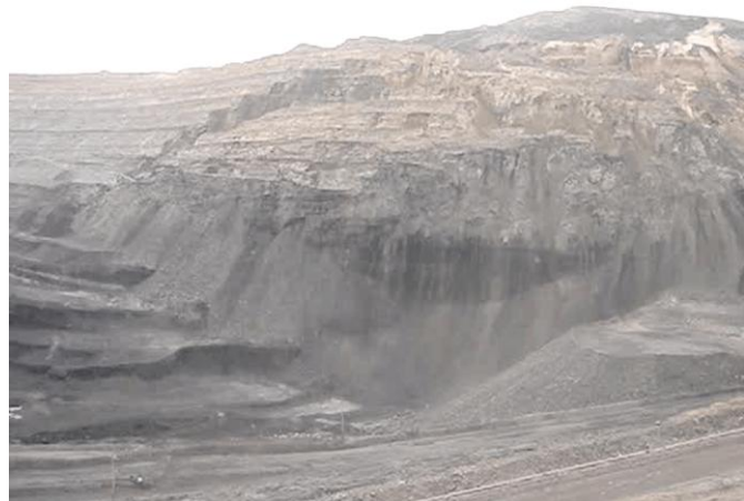
蒙东地区某大型露天煤矿顶帮垮落
