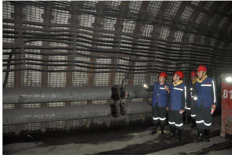
口孜东矿金属支架、壁后充填与锚杆联合支护
