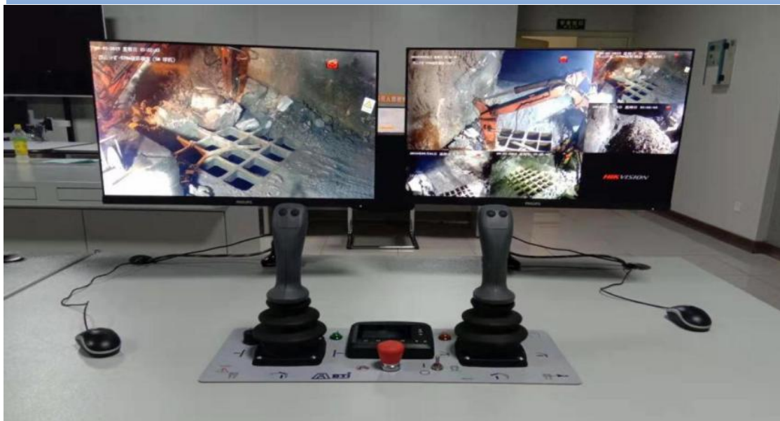
碎石机远程控制系统操作台
