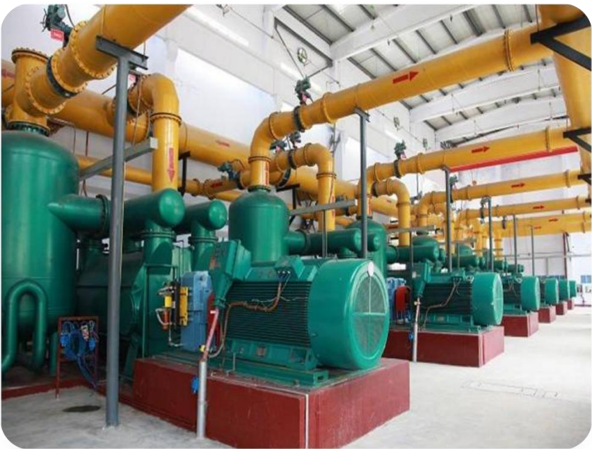
煤矿瓦斯抽采泵站
