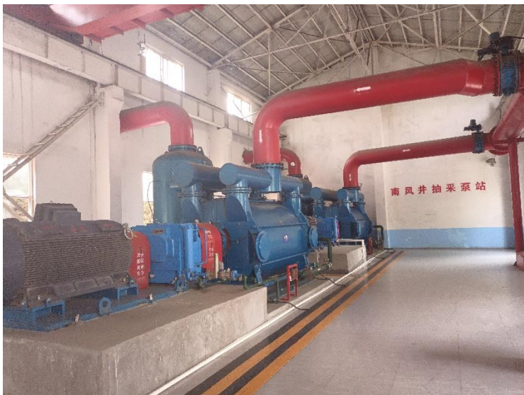
2BEC80大型瓦斯抽采泵
