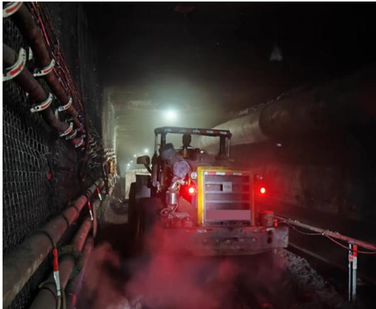
井下柴油车尾气排放CO超标
