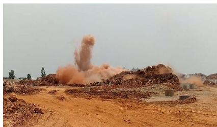
平整场地工程
