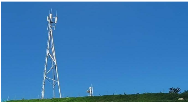
通讯基础设施
