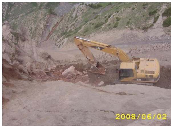
作业平台施工、覆盖堵漏
