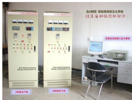
MDZ-60/120地面固定式灌浆注胶防灭火系统
