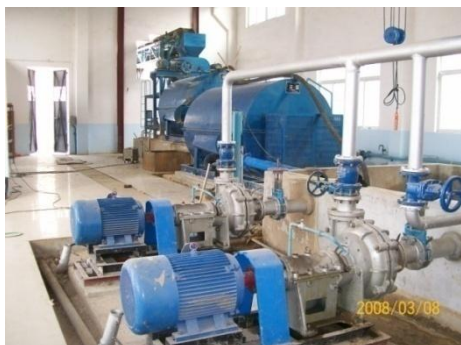
MDZ-60/120地面固定式灌浆注胶防灭火系统
