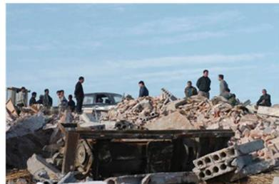
2005年11月6日，河北省邢台县尚汪庄石膏矿区发生采空区坍塌事故，造成33人死亡，4人失踪。**塌陷区**直径约60米，600米×800米范围内地面出现裂缝，地面一幢二层楼坍塌
