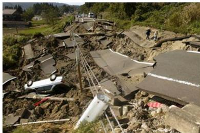
2015年12月25日，山东省平邑县万庄石膏矿区发生采空区坍塌事故，造成1人死亡，13人失踪。事故发生过程中，监测到**M2.4级地震**、**M3.5级地震**，地面产生起伏波动塌陷变形
