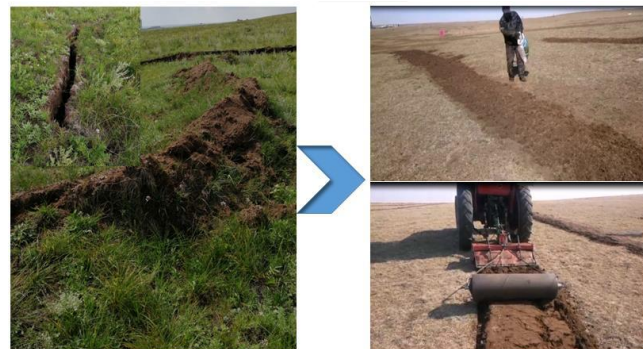
草原开裂隆起损毁治理
