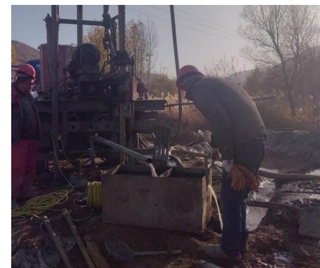
抽水试验现场照片1
