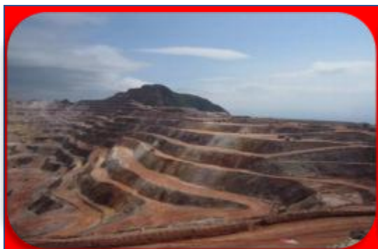
边坡监测系统
