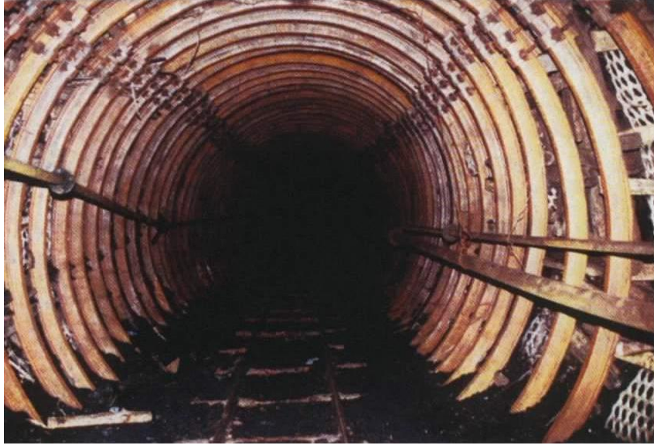
典型冲击地压发生的巷道结构
