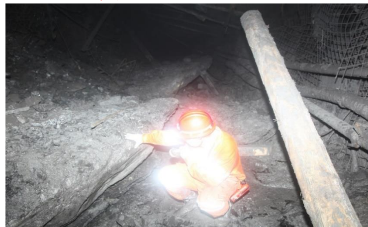
区段煤柱下底板整体冲出，最大量1.5m (超前120-350m)
