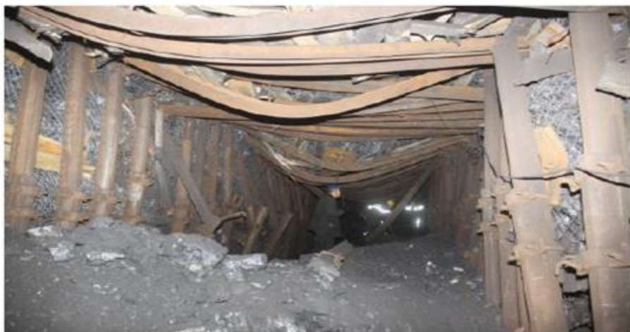
(a) 山西忻州窑煤矿回采巷道冲压破坏
