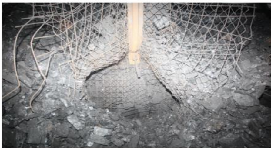
(c) 陕西高家堡煤矿巷帮煤体冲出
