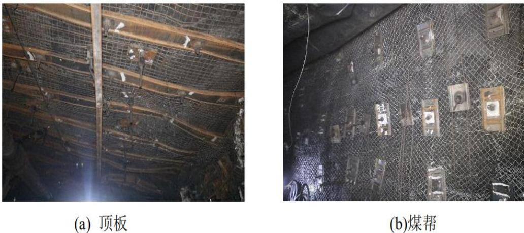
图 8. 小煤柱沿空煤巷围岩控制效果
