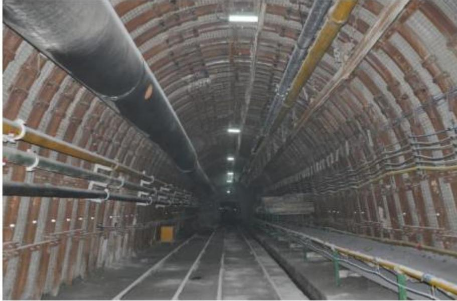
图 6. 西翼轨道大巷支护现场支护效果
