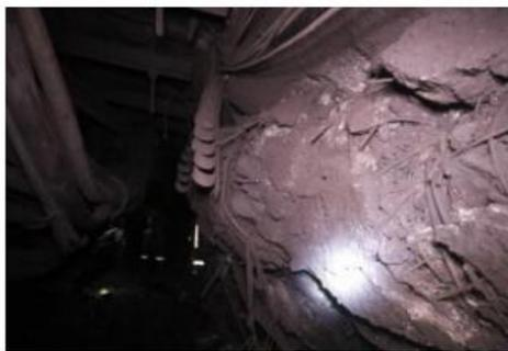
(a) 煤柱侧帮浆皮大范围破裂
