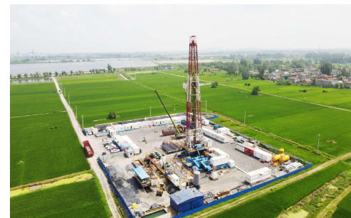
地面钻井瓦斯区域治理
