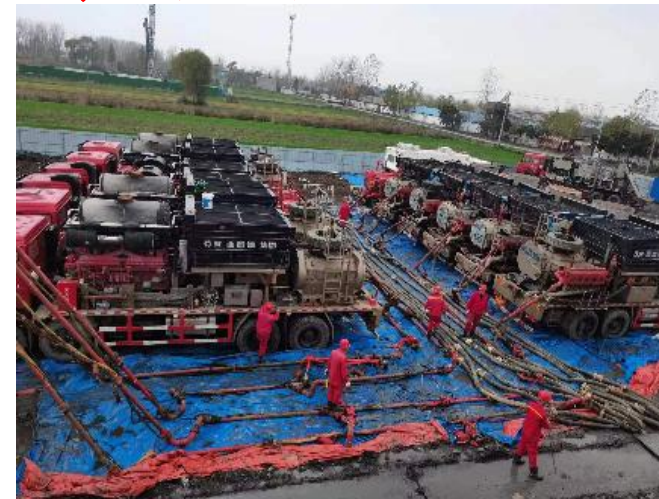
潘三矿二水平东一B组煤饱和提及压裂施工现场
