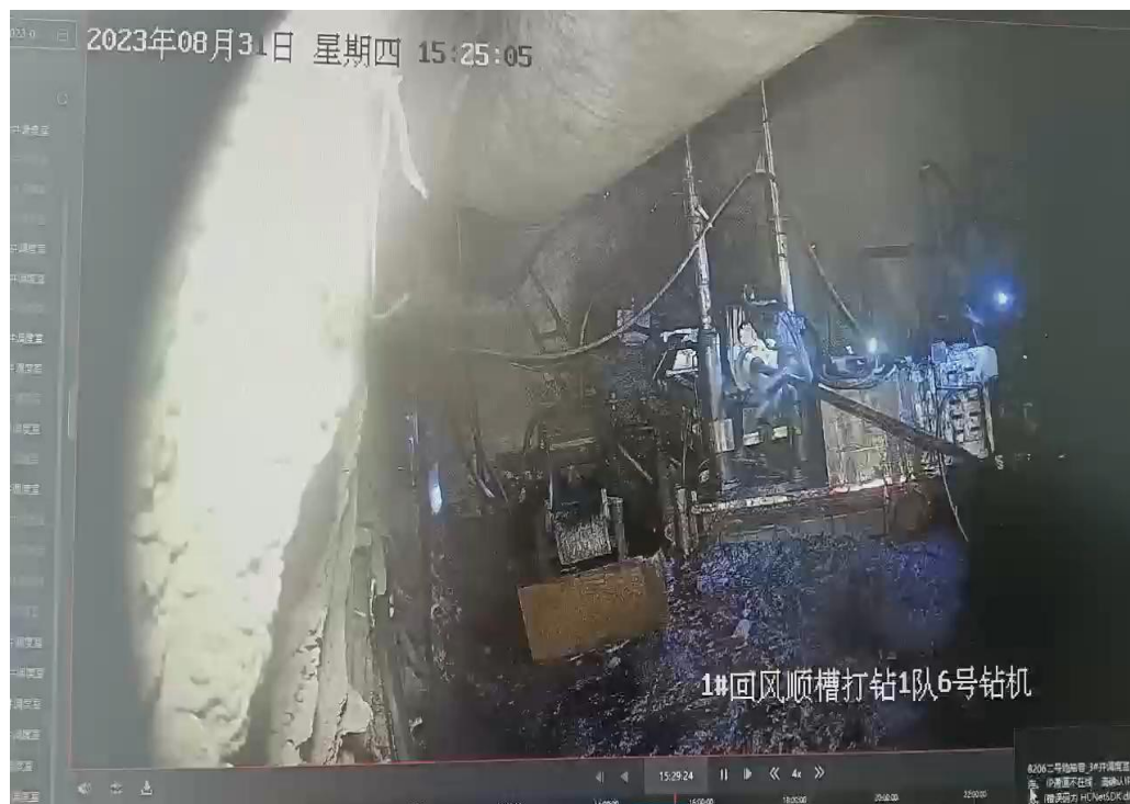
现场剧烈喷孔现象
