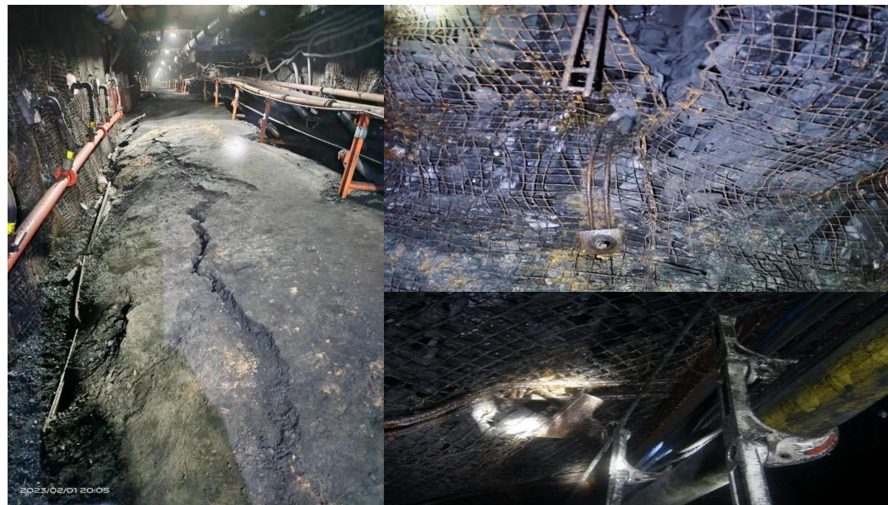
没有大面积采动条件下巷道大变形严重
