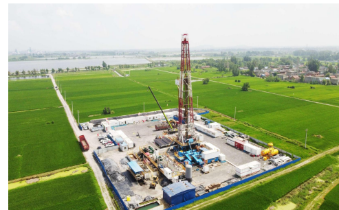
地面钻井瓦斯区域治理
