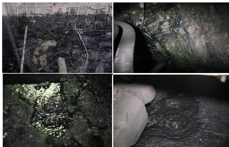
采掘煤壁渗油、底板油型气冒泡
