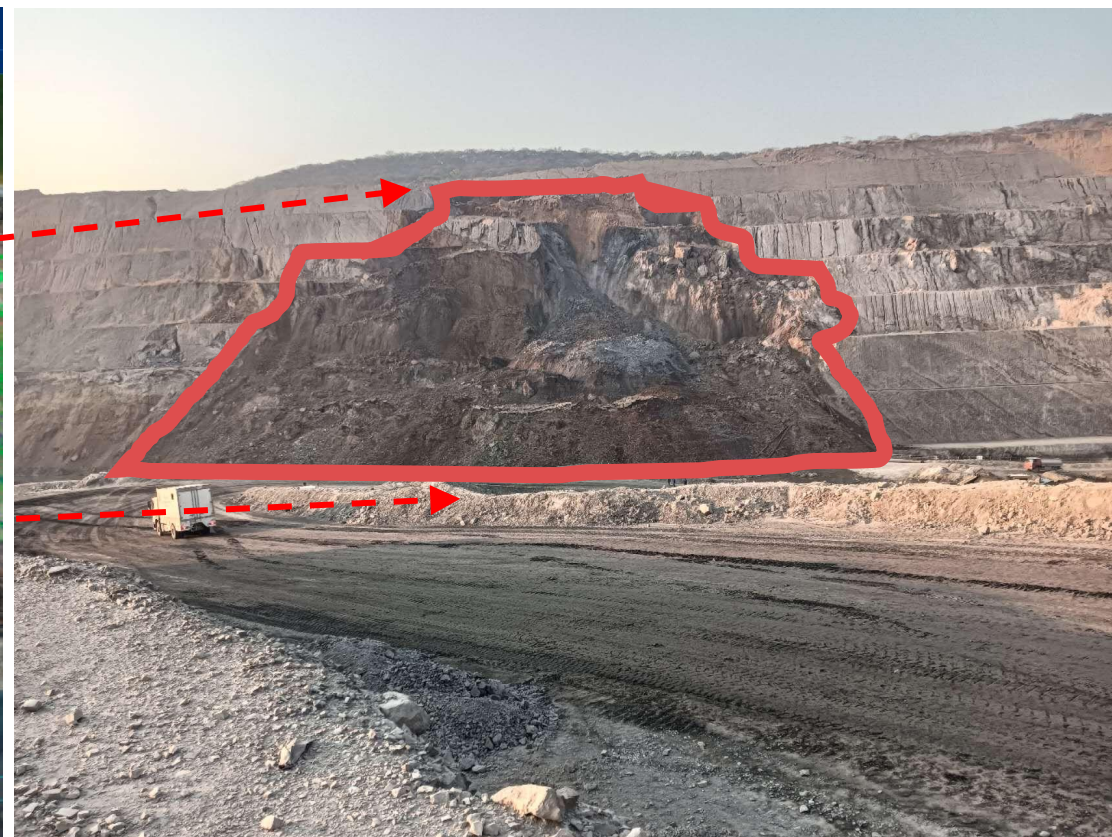
滑坡现场情况
