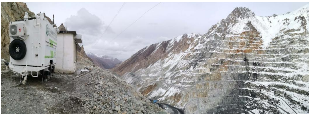
拖车雷达监测边坡的现场情况
