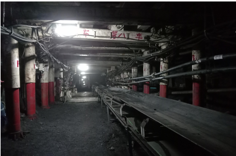
滑移式临时支护装置现场效果
