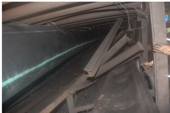
巷道支护失效、破坏现场
