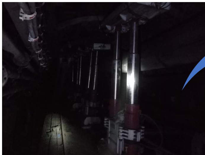
锚网索+36U钢+液压抬棚
