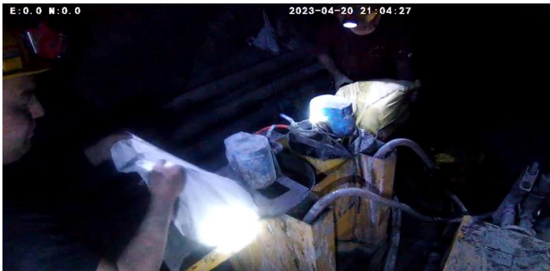
断顶爆破现场装药环节图
