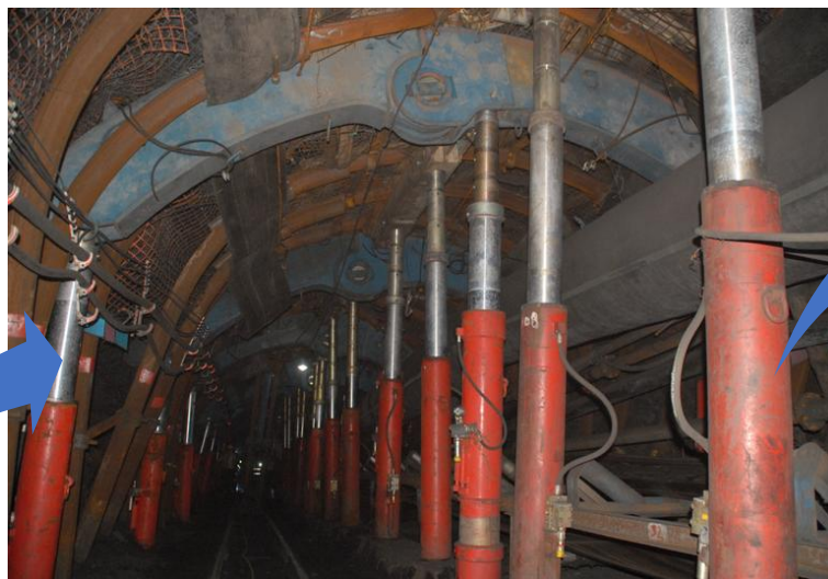
锚网索+36U钢+液压抬棚/门式支架复合支护
